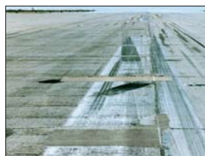
Аэропорт Leipzig/Halle: Ремонт бетонного основания взлетно-посадочных полос, въездов
