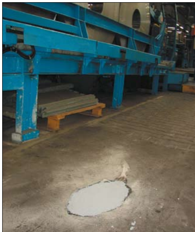
Вверху: Компания MHP Mannesmann Präzisionsrohr GmbH, Hamm: Ремонт выбоин в основании
