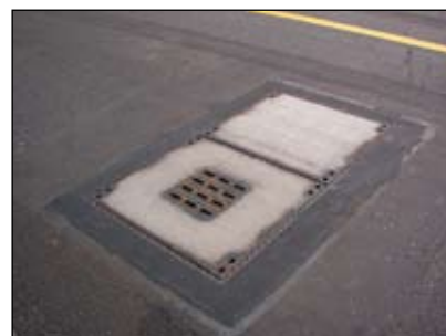
Аэропорт Nordrhein-Westfalen: Выравнивание кабельных люков, раствором R 17 под цвет асфальта
