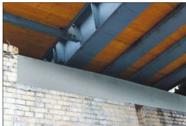
Метромост в г. Берлине, Sterndamm: Ремонт опор моста
