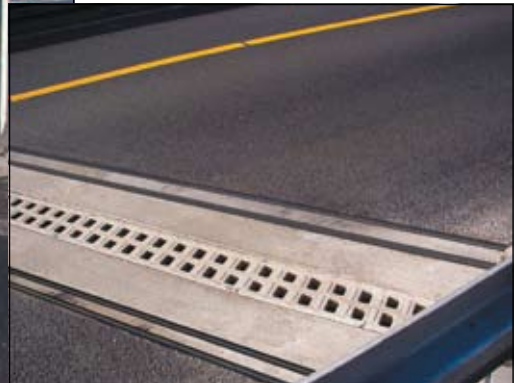
Автотрасса А2, Намм-Уентроп: Устройство поперечных дренажных стоков
