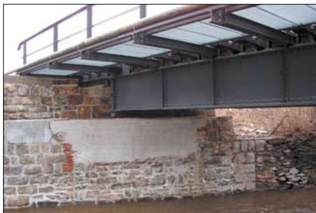
Путепровод Chemnitz-Einsiedel, улица Blankenauer: Ремонт опор моста
