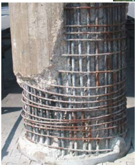
Ремонт бетонных столбов, разрушенных антигололедными солями
