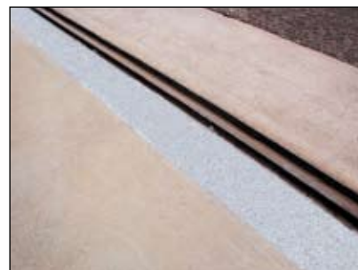
Аэропорт в Mannheim: Строительство основания для колеи разводных ворот
