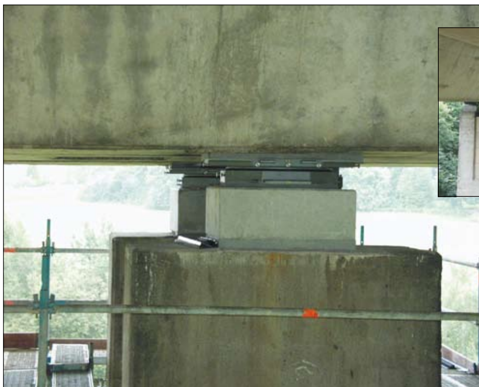
Мост на трассе A7, Uttrichshausen: Ремонт опор моста
