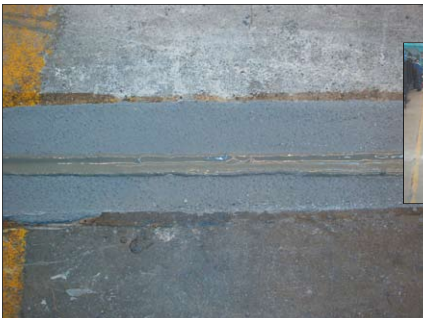
Компания Fahrzeugwerke Faymonville AG, Billingen/Belgium: Ремонт швов расширения
