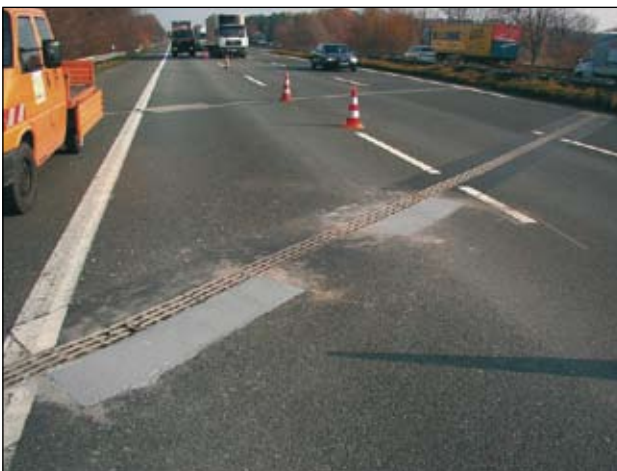
Автотрасса А2, Билефельд: Ремонт поперечных дренажных стоков
