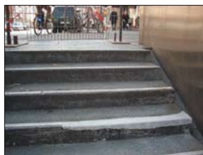
Ремонт ступеней станции метро на улице Venloer в Кельне
