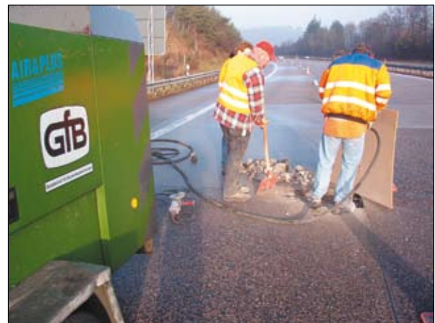
Автотрасса А3, Неустадт/Вьед: Ремонт покрытия дороги
