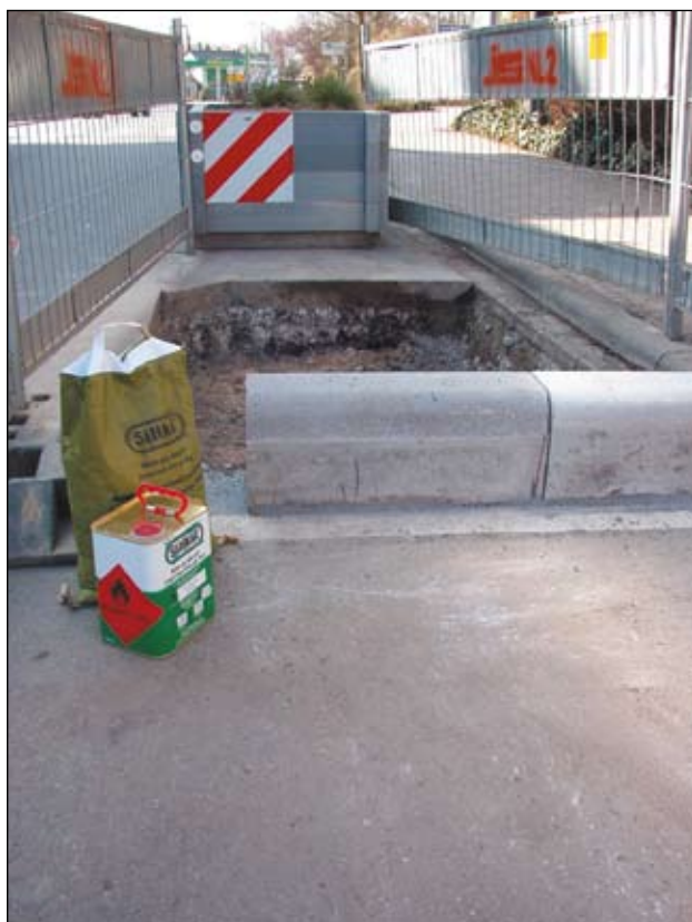
Ladenburg, улица Schriesheimer: Строительство цветника, огороженного бордюром камнем, на асфальте с применением раствора SILIKAL® R 17
