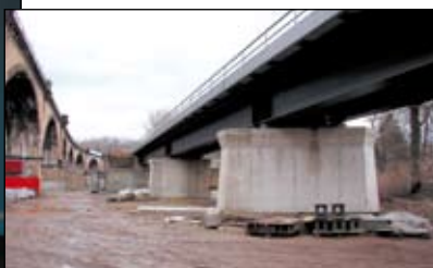
Строительство путепровода в Chemnitz: Строительство бетонных опор в зимнее время
