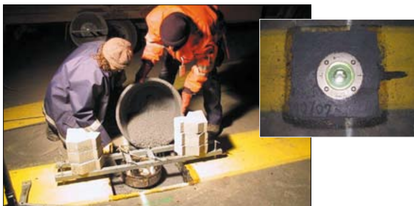
Аэропорт Nordrhein-Westfalen: Замена и установка встроенных огней на взлетной полосе без остановки движения самолетов
