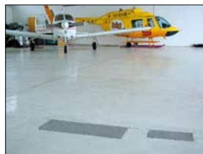
Аэропорт в г. Mannheim Ремонт полов в ангаре
