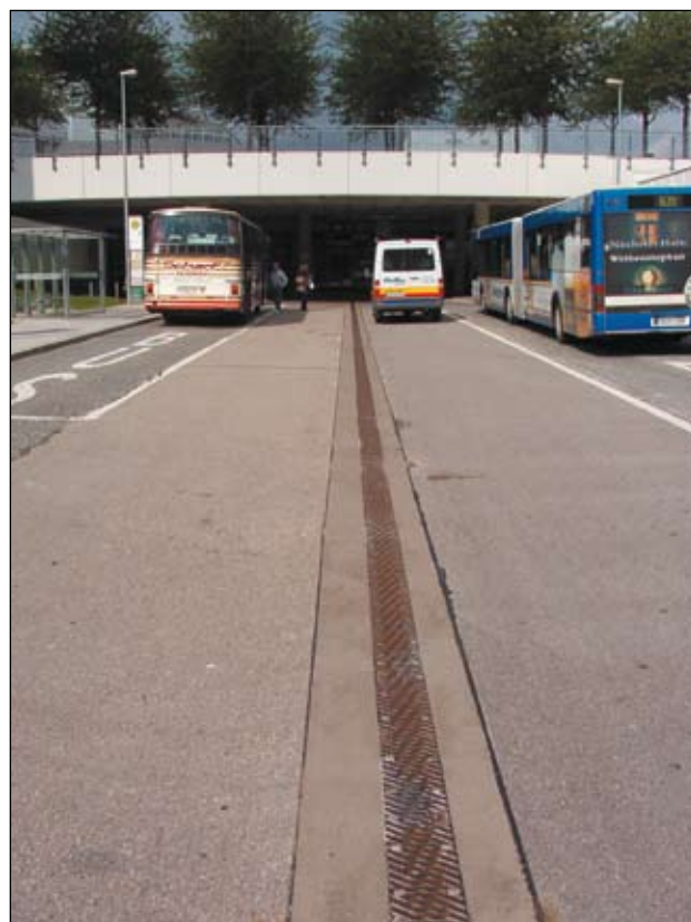
Южная автостанция аэропорта "Franz-Josef Strauss", Мюнхен: Ремонт дренажных стоков
