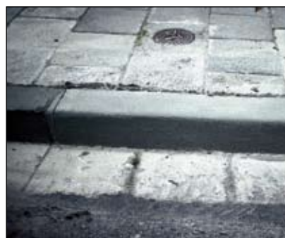
Ремонт бордюров раствором SILIKAL® R 17
