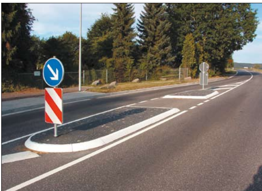
106 км по дороге Neuwied-Niederbieber: Островок безопасности построенный на асфальте с применением раствора SILIKAL® R 17
