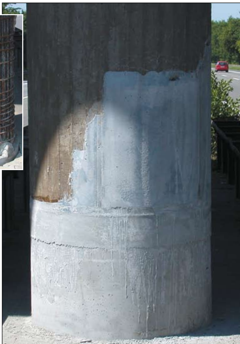
Ремонт бетонных столбов, разрушенных антигололедными солями
