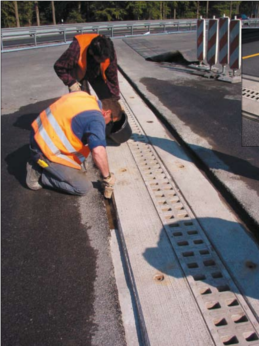
Автотрасса А2, Намм-Уентроп: Устройство поперечных дренажных стоков
